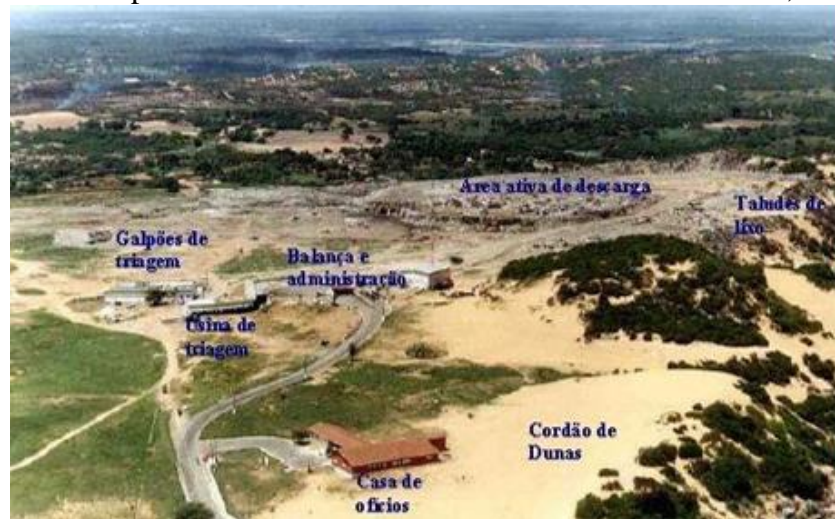
Figura 7: Vista panorâmica da área de transbordo em Cidade Nova, Natal-RN.
