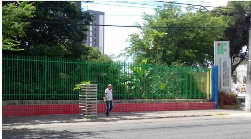
Figura 4: Após reforma retirada do muro da frente e uso de grades no campus Natal /Central.
