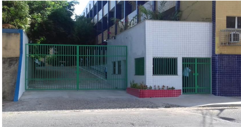
Figura 2: Depois da reforma, Guarita e entrada dos carros no campus Natal Central com entrada de acessibilidade para cadeirantes.
